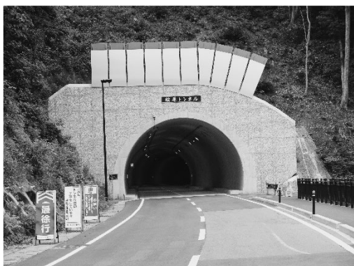
平成26年4月に完成した桧原トンネル
