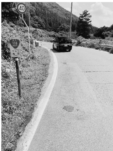
二川橋付近の狭隘な 118 号
