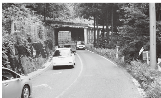
三島町滝原地内のスノーシェッド
